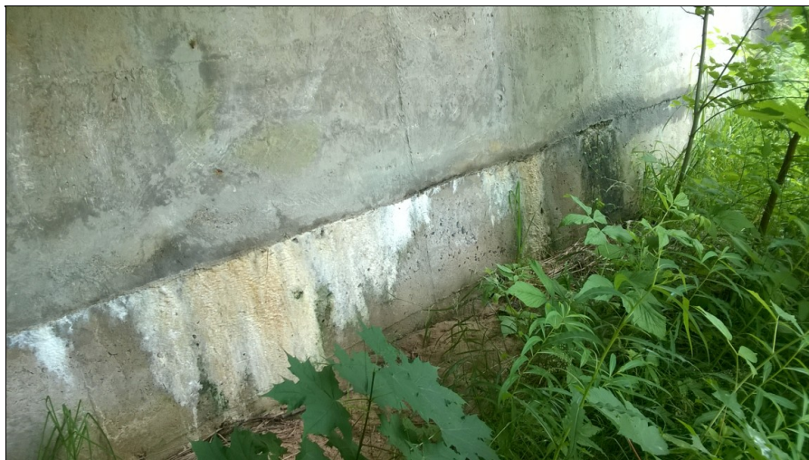
Zatékání do pracovní spáry mezi základy a dříky opěr
