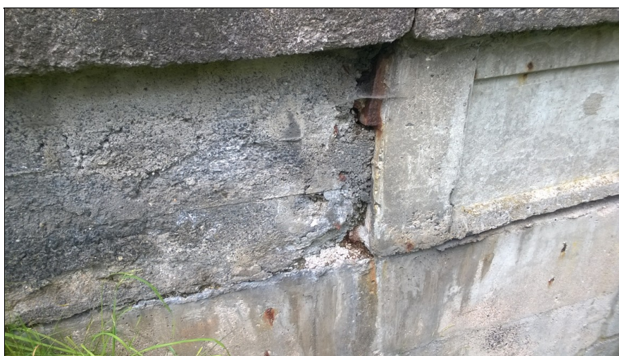
Viditelné povrchově zkorodované kotvy předpětí - levobřežní vtok
